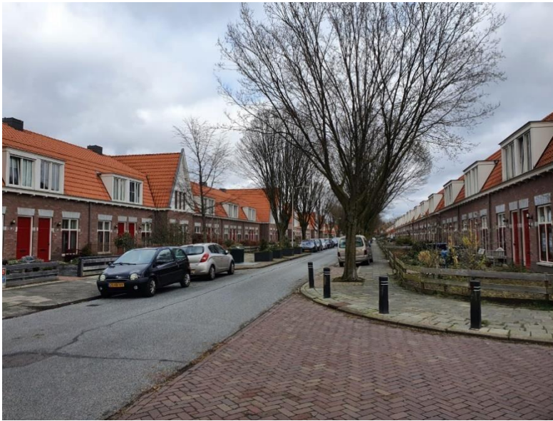
Foto 4: Renovatie Dr. Schaepmanlaan
