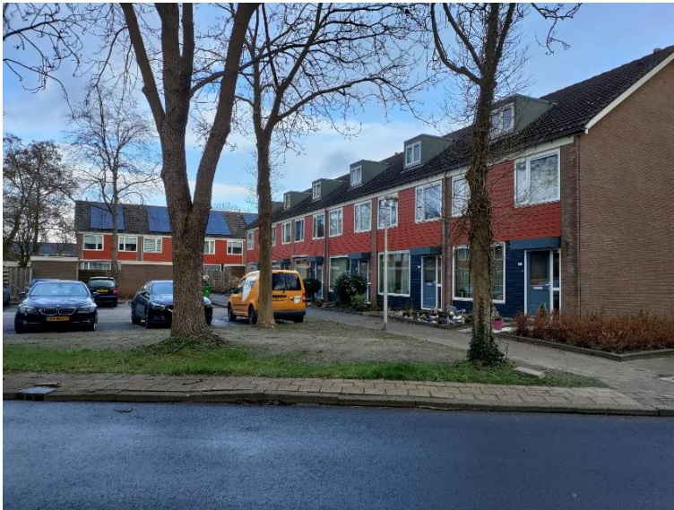
Foto 2: Renovatie en verduurzamingen woningen Couwenhoven
